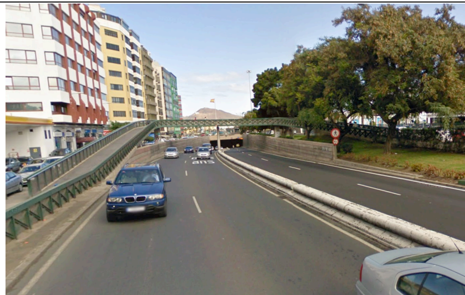
DENOMINACIÓN: Pasarela Peatonal sobre autovía GC 1 ORIGEN: Salvar la autovía para conectar con la playa de las Alcaravaneras y con el Club Náutico FECHA: Construcción año 1998 OBSERVACIONES: Era un punto conflictivo con numerosos accidentes por lo que una de las soluciones fue construir este paso peatonal elevado
