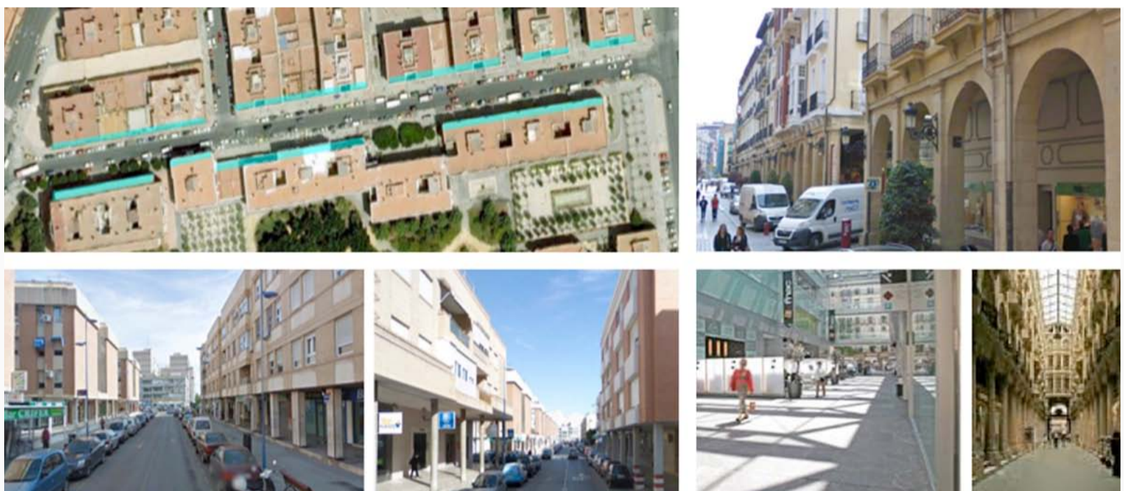
Figura 4. Los soportales y los pasajes son elementos peatonales históricos que se usan desde la época medieval hasta la actualidad, mejorando el desplazamiento del peatón por la ciudad. Fuente: fotos izquierda, arriba elaboración propia sobre ortofoto del Google Earth, año 2010; abajo Google Maps año 2012; fotos derecha, arriba Google Maps, año 2012; abajo derecha, elaboración propia; abajo izquierda, recuperado de http://www.memoriescollectionblog.com/2010/08/unrecorrido-pormercadosespanoles.html
