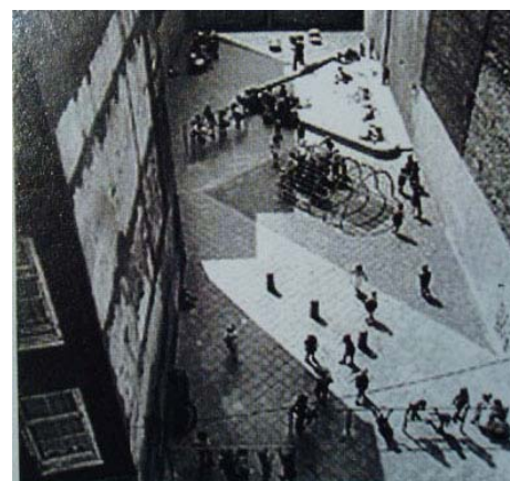
Antes y después de una intervención en un solar
